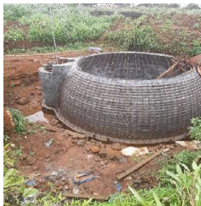
Fig. 107: Digestor (Wasaza model)
