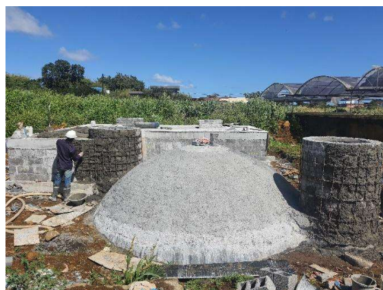
Fig. 107: Digestor (Wasaza model)
